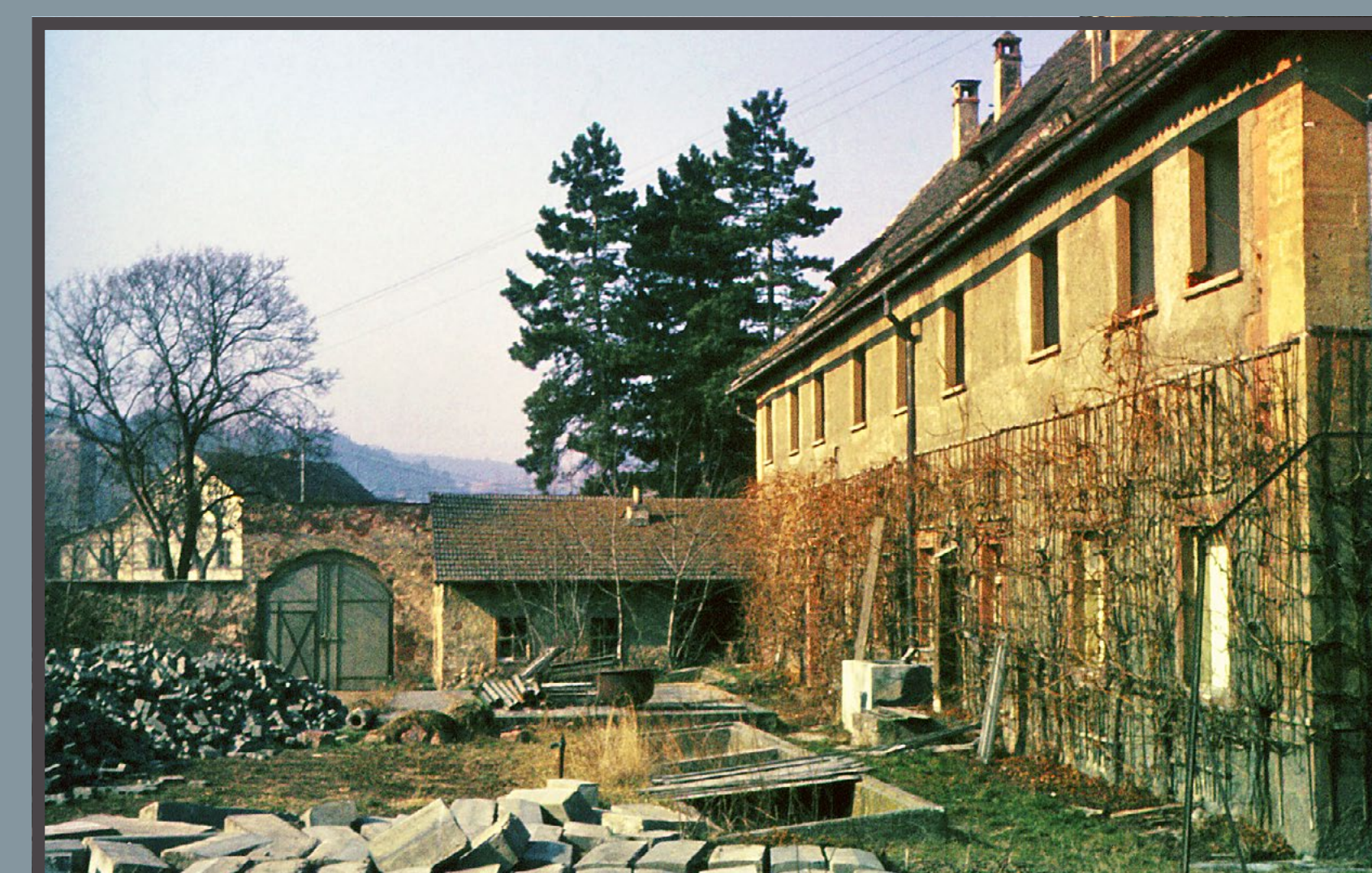
Blick von Süden auf das Klostergebäude
